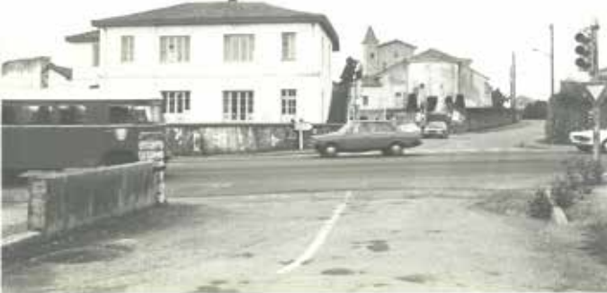
Photographie noir et blanc de l'ancienne école Jean Mouchet avant sa destruction, sans date Archives Municipales de Tarnos Photothèque, série 5Com Bâtiments- Lieux publics
