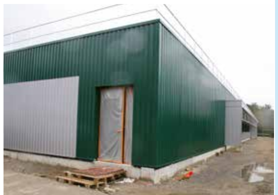
10 Les ateliers municipaux sont en cours de réhabilitation.
