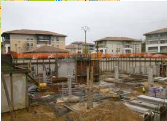
7 Le projet Artigaous plante ses fondations (bureaux et commerces principalement).
