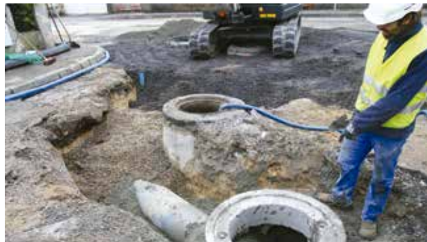
De conséquents et indispensables travaux d'agrandissement des réseaux d'assainissement ont été menés sur l'avenue Lénine.
