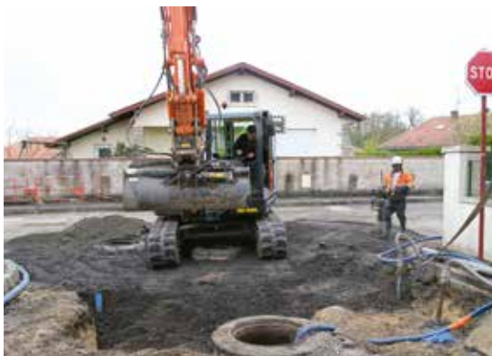
11 Avenue Lénine, les travaux de réhabilitation du réseau d'assainissement des eaux usées, élément fondamental de la lutte contre les inondations de tout l'Ouest de la commune, touchent à leur fin.
