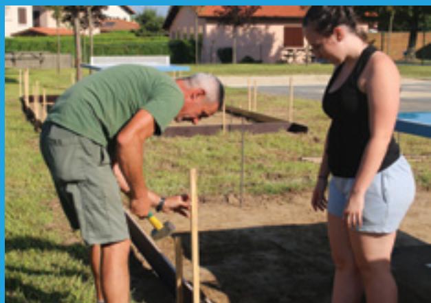
Les cours de récré ne sont pas en reste. Ici, on améliore la dalle de béton des tables de ping-pong pour que les écolier·e·s puissent mieux en profiter.
