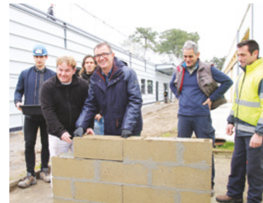
Pose de la première pierre des nouveaux bâtiments du Centre Technique Municipal, le 8 février 2018
