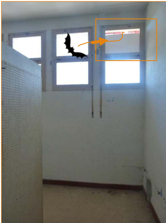
Aménagement réalisé au niveau des fenêtres des sanitaires
