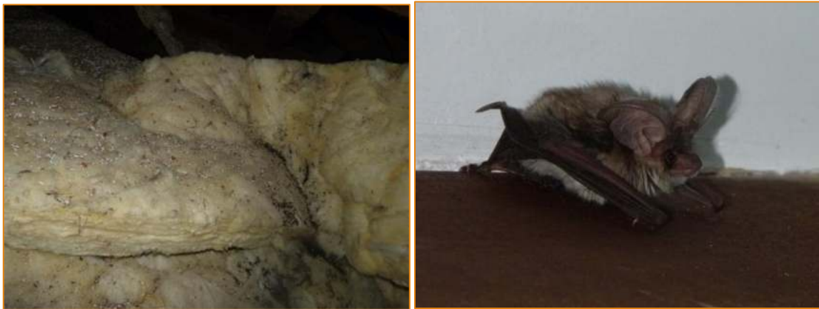
Traces de guano dans les combles ; Oreillard observé dans le premier étage du bâtiment principal
