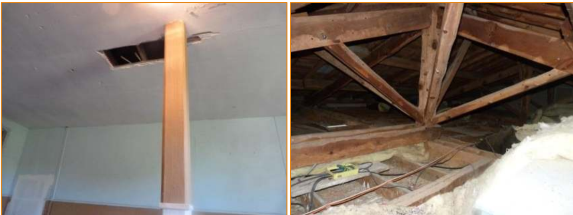
Ouvertures dans le plafond permettant l'accès entre le premier étage et les combles avec charpente en bois
