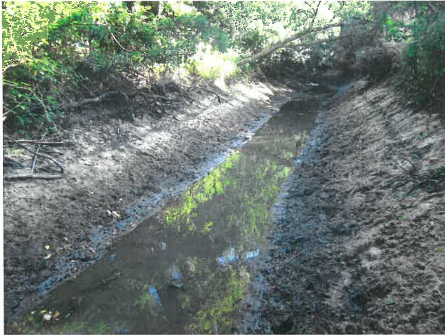
Juillet 2016 : portion ombragée du cours d'eau de l'Aygas après intervention
