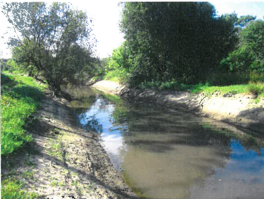
Juillet 2016 : zone de chantier sur la portion de l'Aygas traversant les étangs de la Baleye
